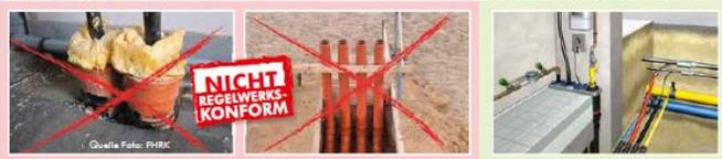
Im Bereich der Haus- und Netzanschlüsse werden häufig Rohre zweckfremd eingesetzt (siehe Bilder). Die Anwendung als Durchführungssystem entspricht nicht dem Stand der Technik und ist für eine dauerhaft sichere Abdichtung gemäß der nachfolgenden Regelwerke nicht geeignet!
