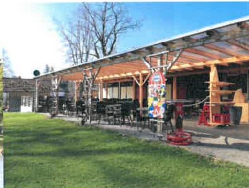
Kiosk, Ansicht von Süden
