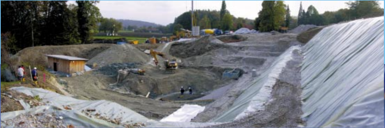
Gesamtansicht der Sanierungsbaustelle an der Quelle in Bischofsried
