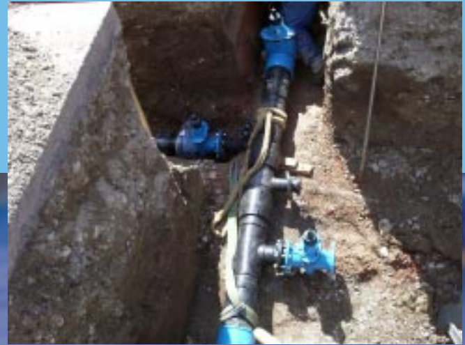
Vierfach Kreuzung einer Wasserleitung
