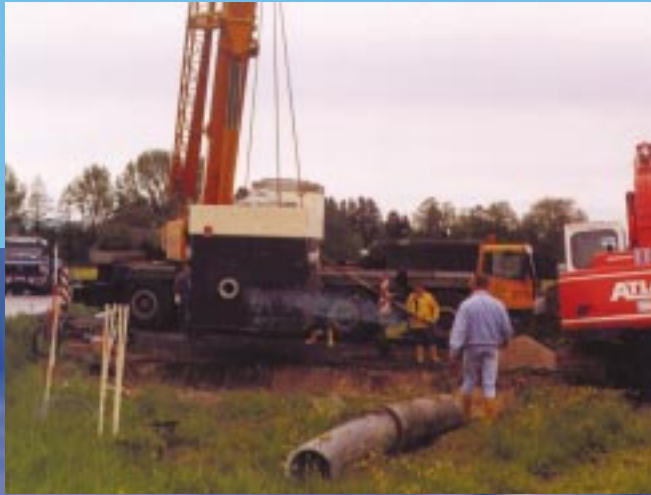
Einbau des Kreuzungsbauwerkes der Dießener Wasserversorgung und der Leitung des ZV Ammersee West
