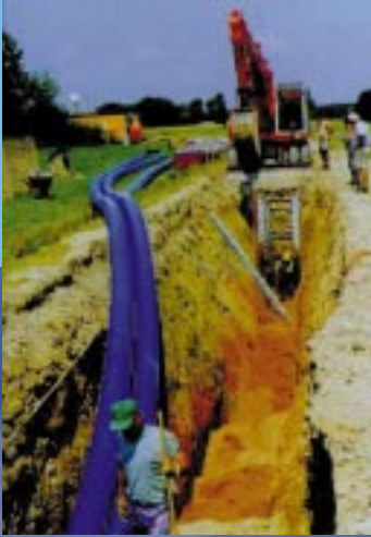
Bau der Zubringer- leitungen am Hochbehälter Dießen
