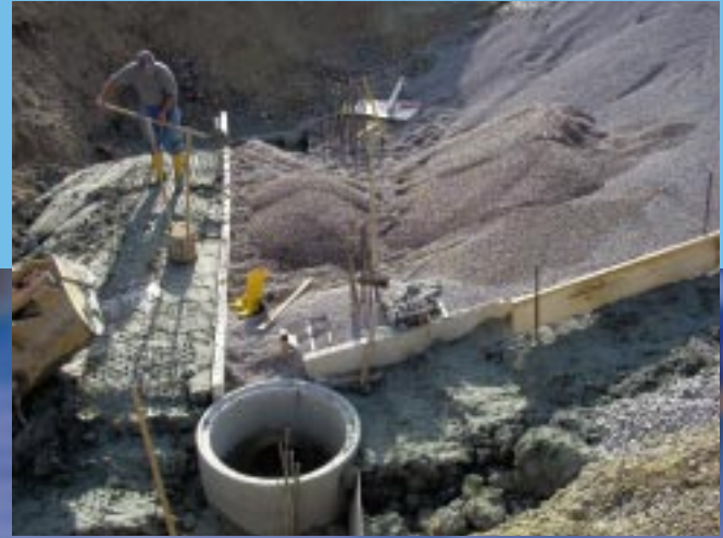
Aufbau einer Quellfassung
