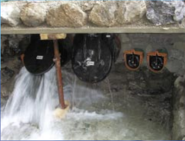
Ablauf des Überwassers in den Wasen- meisterbach
