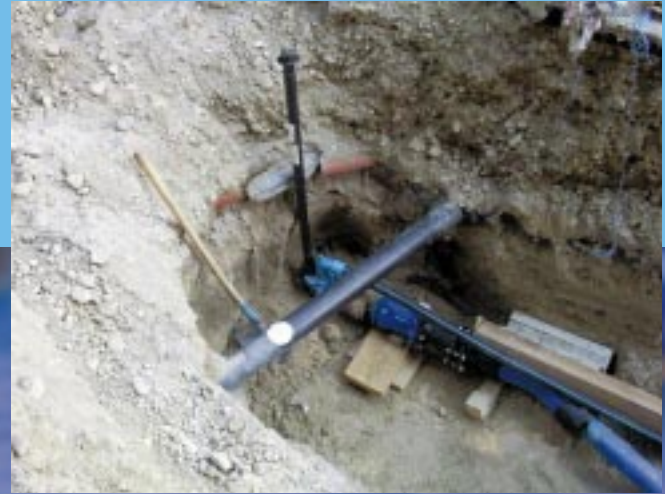
Wasserleitungs- bau mit Notversorgung
