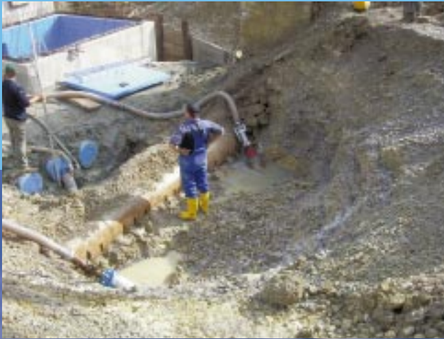
Die Rohre der alten Quelfassung von 1900
