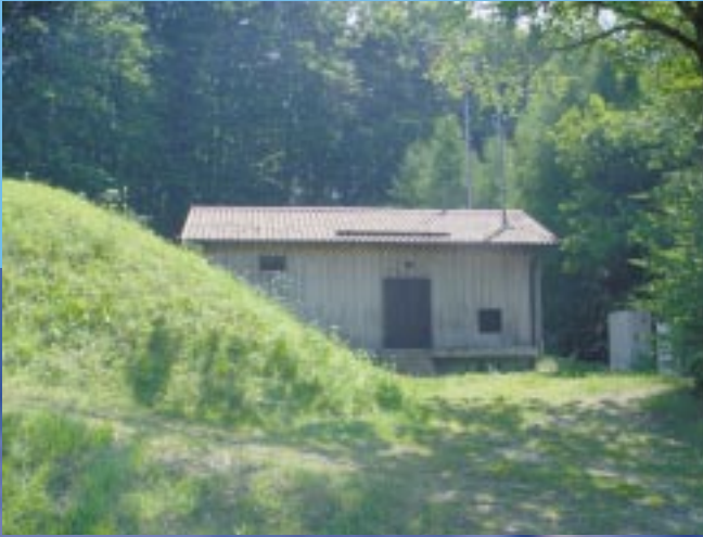
Hochbehälter Dettenhofen „Pitzeshofen“
