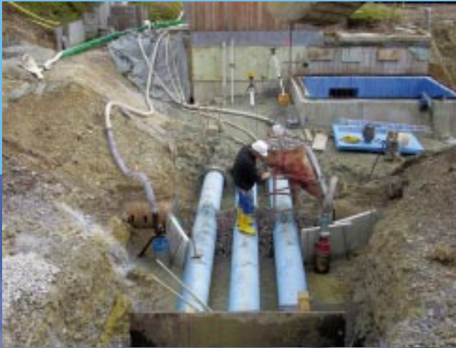
Einlauf der drei Quellstränge in das Quellhaus
