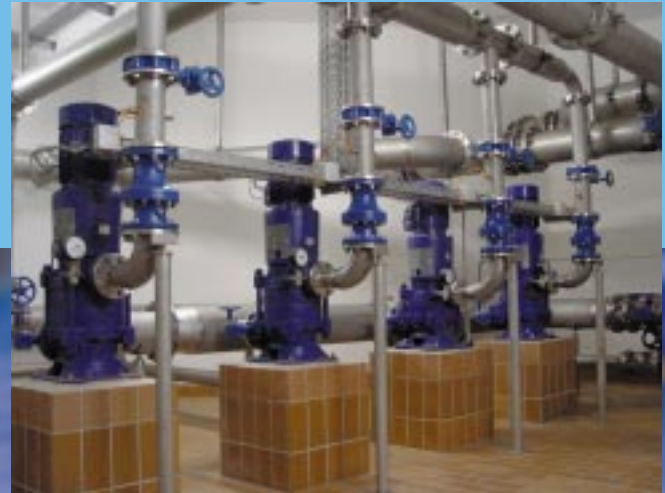
Druckerhöhungsanlage
