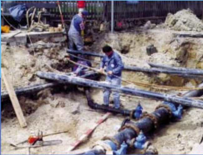
Wasserleitungs- bau unter erschweren Bedingungen
