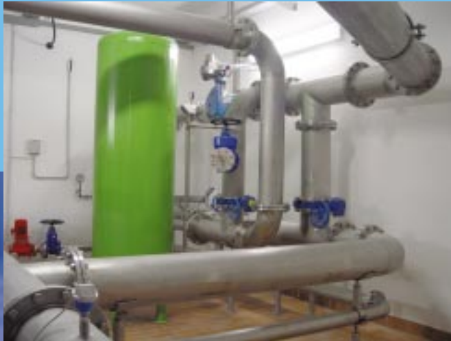
Druckausgleichsbehälter
