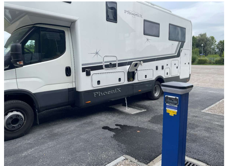
Neue Ver- und Entsorgungsstation für Camper
