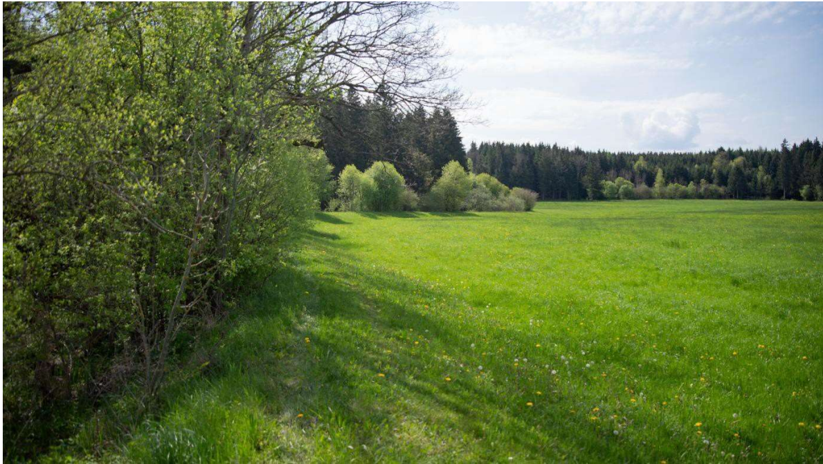
Blick auf den Hochwasserdamm von Norden nach Süden
