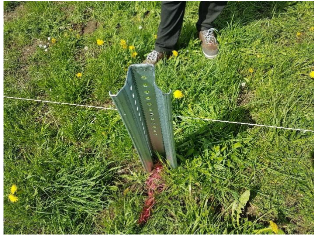
Abbildung 5: Rammfundament
