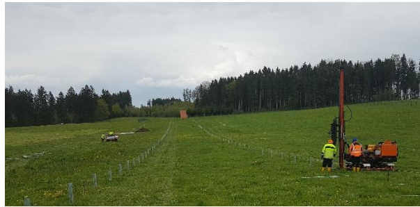
Abbildung 2: Hydraulikramme auf Ketten
