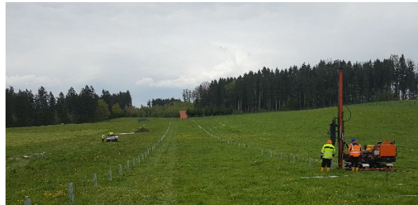
Abbildung 2: Hydraulikramme auf Ketten
