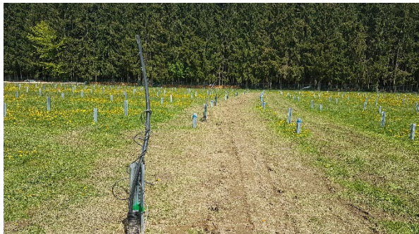
Abbildung 3: Verfüllter Kabelgraben
